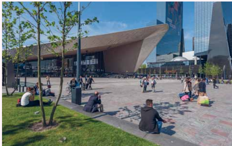
Het nieuwe Centraal Station van Rotterdam, een belangrijke economische motor van het zakendistrict Rotterdam Central District (RCD).
